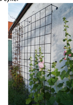
Väggspaljé av obehandlad armeringsnät.
